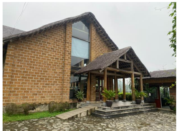
Khu nhà đón tiếp kết hợp dịch vụ
